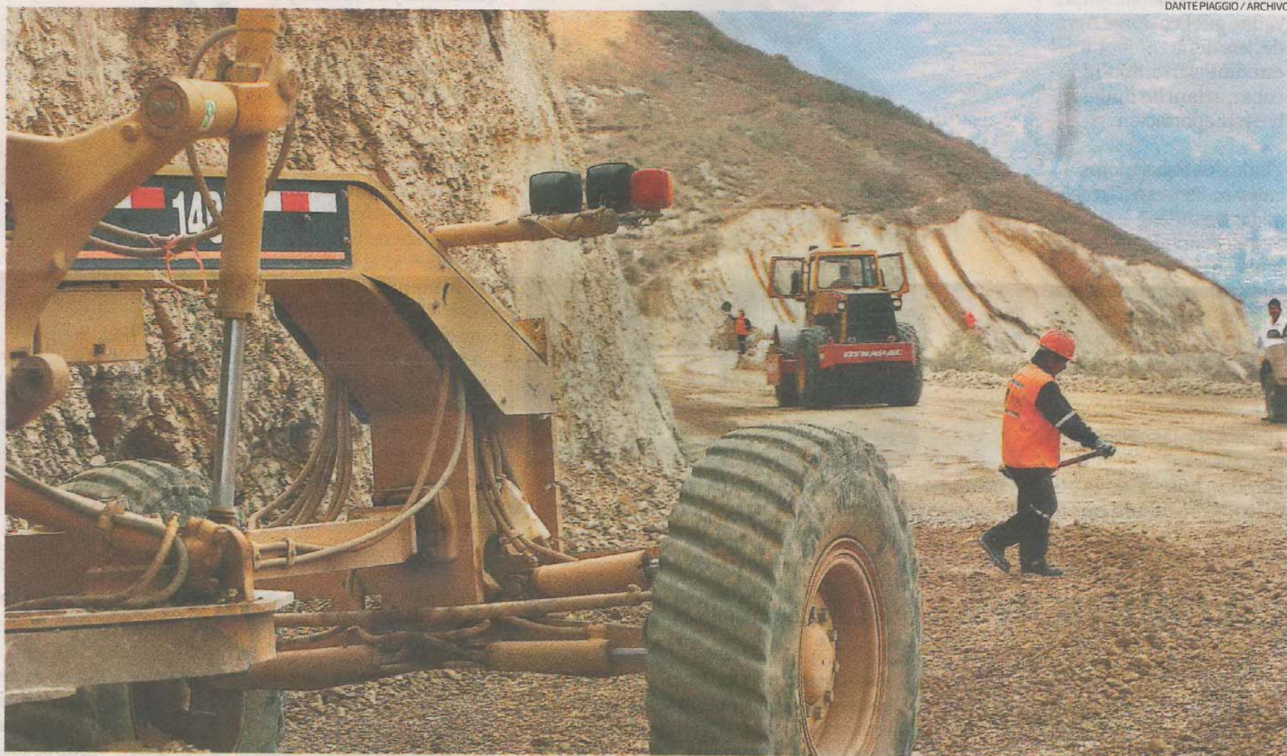
PARRILLA. Los recursos del Fonie pueden ayudar a concretar la parrilla carretera que se necesita para interconectar el país.
